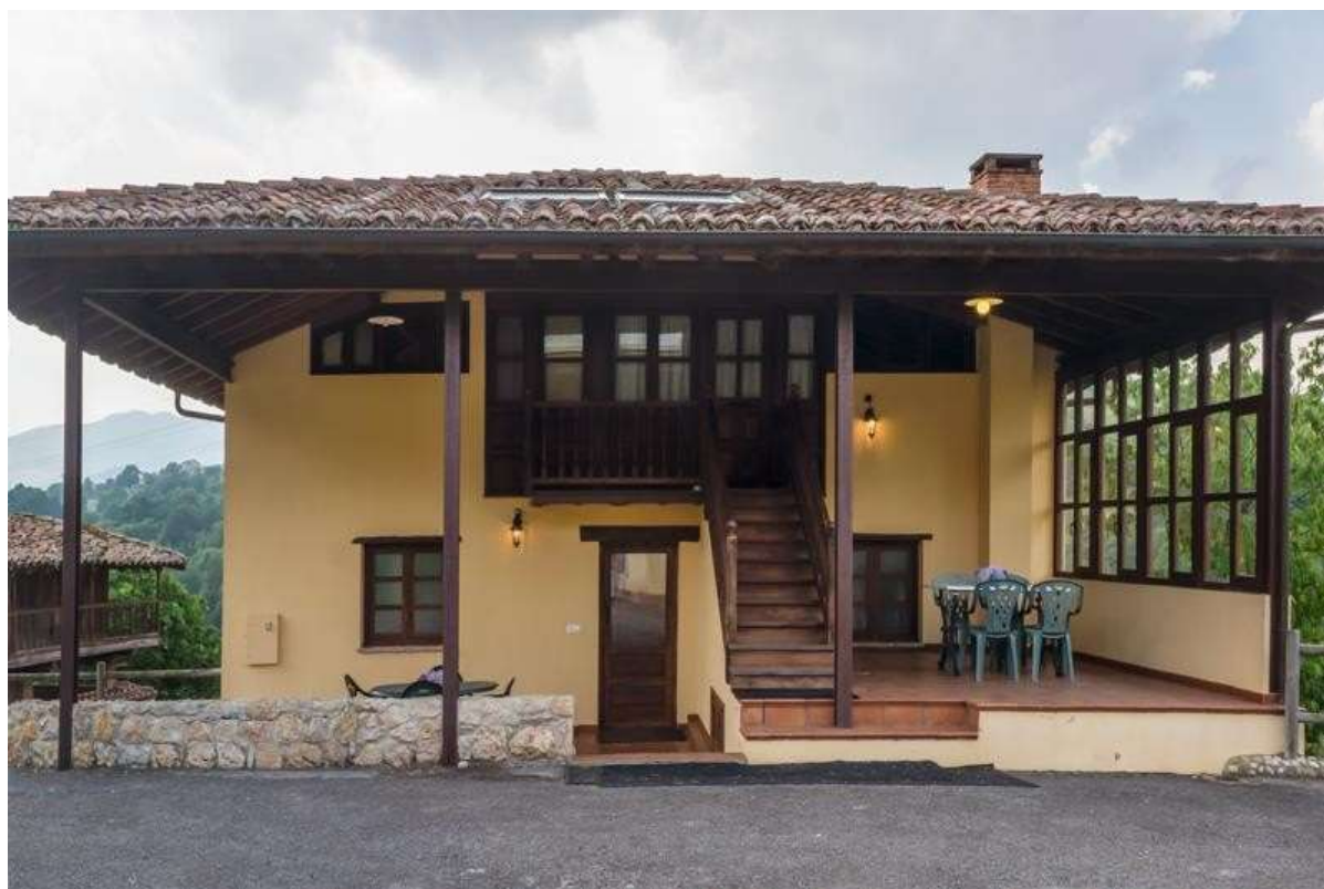
Fachada Norte, acceso a la Casa de la 2ª y 3ª Planta
